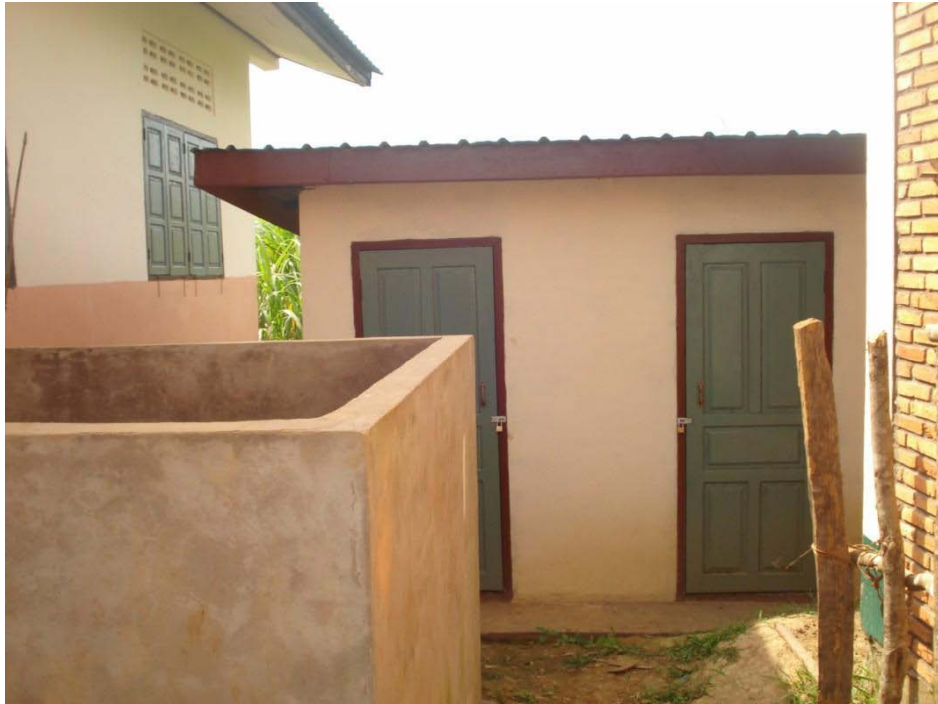
新設されたトイレ
